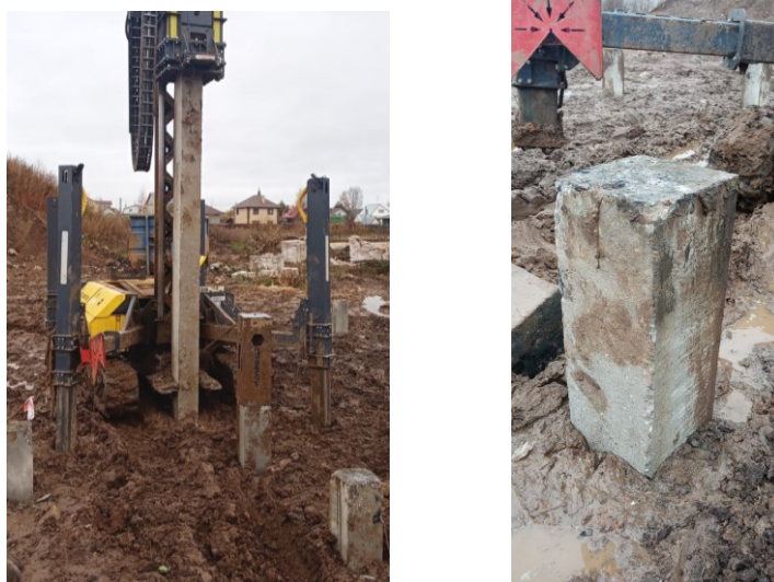
Рис. 3. Забивка свай, армированных АСК, на строительной площадке
