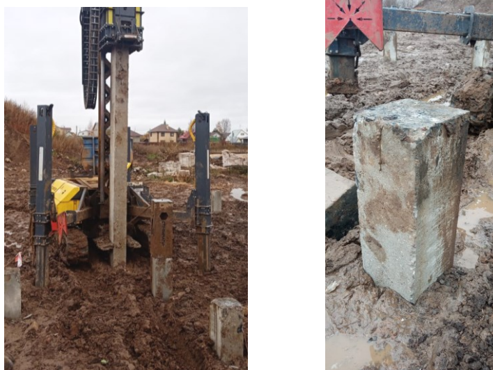
Рис. 3. Забивка свай, армированных АСК, на строительной площадке
