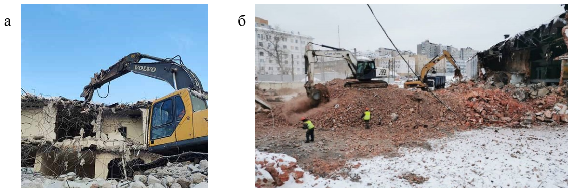
Рис. 1. Снос старых зданий: а – из железобетонных панелей; б – кирпича
