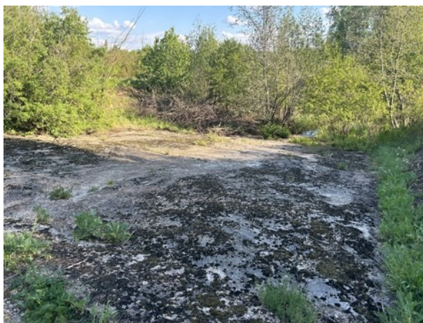
Рис. 3. Бетонированный канал катастрофического сброса
