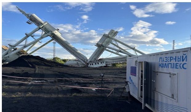
Рис. 1. Демонтаж кранов-перегрузателей в г. Кургане с помощью МЛК
