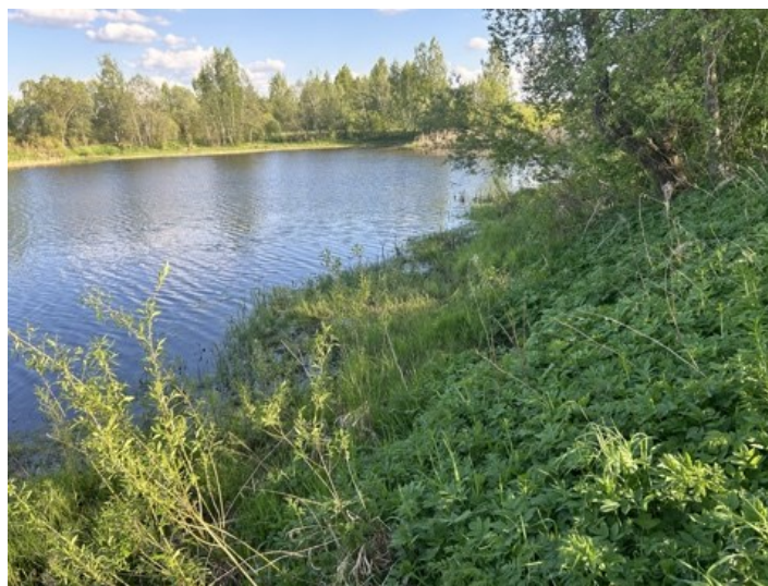
Рис. 4. Разрушение откоса под действием ветро-волновой эрозии
