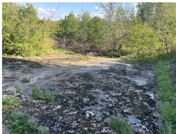
Рис. 3. Бетонированный канал катастрофического сброса
