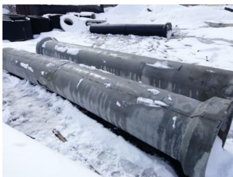
Рис. 5. Неправильное складирование труб и последствия
