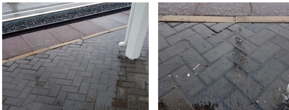
Рис. 9. Скопление воды на платформе
