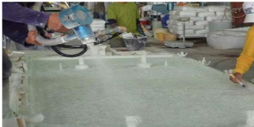
Рис. 4. Технология торкретирования [13]
