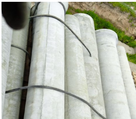
Рис. 4. Резиновые прокладки между трубами
