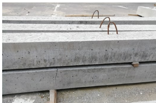
Рис. 2. Неправильное складирование перемычек
