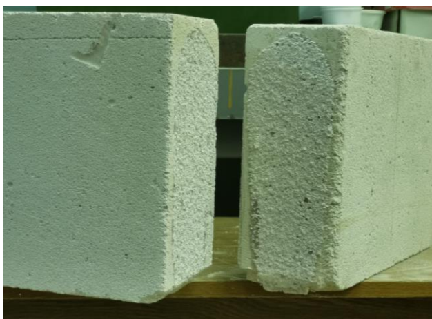
Рис. 4. Типичный вид торцов блоков после разрушения перемычки
