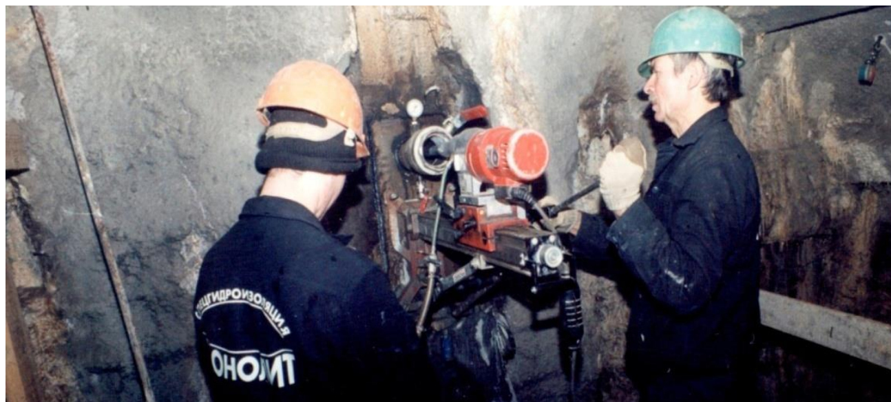
Рис. 4. Алмазное бурение разведочной скважины через пробку заглушенного аварийного участка перегонного тоннеля метрополитена «Пл. Мужества» – «Лесная», г. Санкт-Петербург
