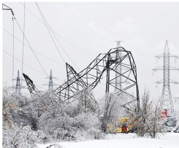
Рис. 2. Поломка металлической опоры [1]
