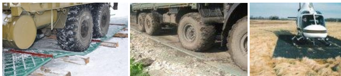
Рис. 1. Пример устройства быстровозводимого временного дорожного полотна из композитных замковых плит МДП ООО «Русполимер Групп»: использование в зимних условиях (а); временное дорожное полотно (б); временная вертолетная площадка (в)
