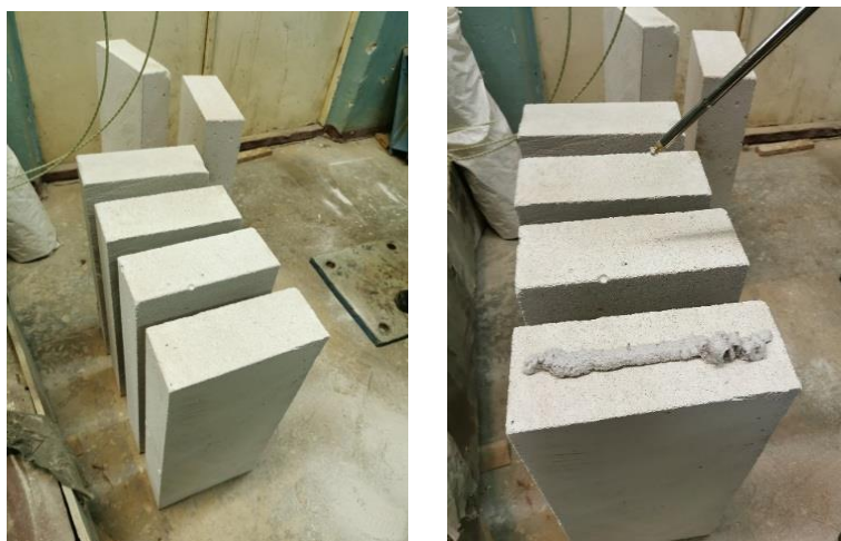
Рис. 1. Процесс нанесения клей-пены на газобетонные заготовки
