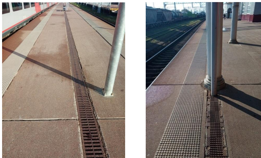
Рис. 7. Водоотвод платформы
