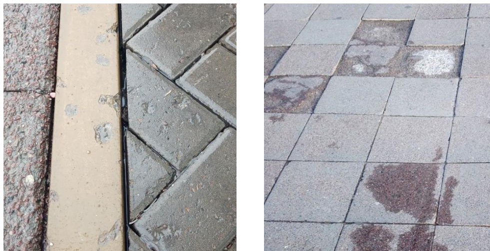
Рис. 5. Сколы на платформе при механических воздействиях
