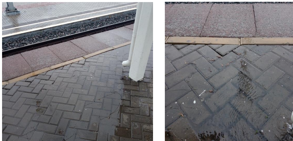
Рис. 6. Скопление воды на платформе
