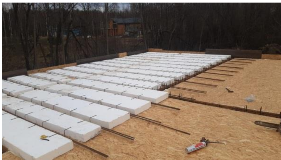
Рис. 1. Поперечное сечение монолитного часторёбристого перекрытия, сделанного с использованием заводских элементов
