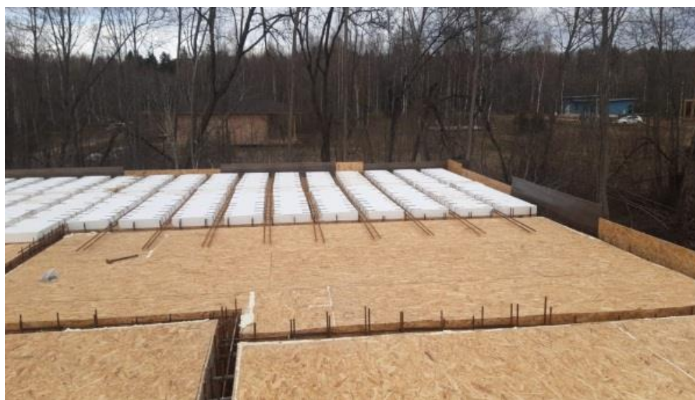
Рис. 2. Общий вид процесса монтажа часторёбристого сборно-монолитного перекрытия без заводских элементов
