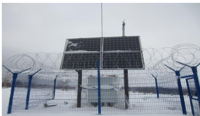
Рис. 2. Конструкция для установки КП ТМ с солнечными модулями (Пермский край)
